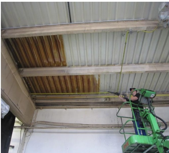
(Eingebrannte Ölablagerungen von zwei Härteanlagen)
