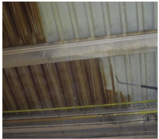
(Eingebrannte Ölablagerungen von zwei Härteanlagen)
