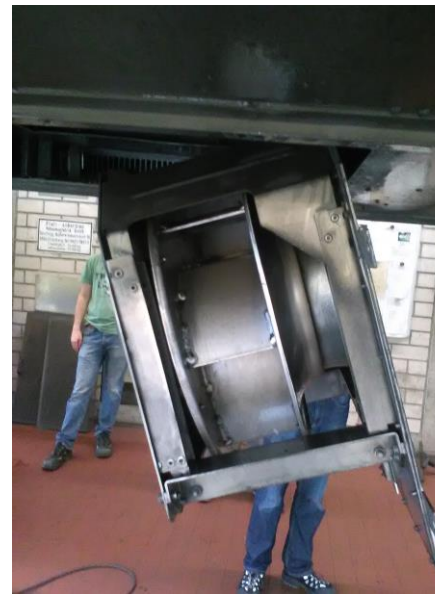
Reinigung eines Wärmetauschers direkt unter einer S-Bahn
