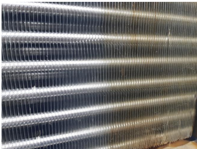
Niederdruck-Heißreinigungsverfahren: Vor und nach der Reinigung
