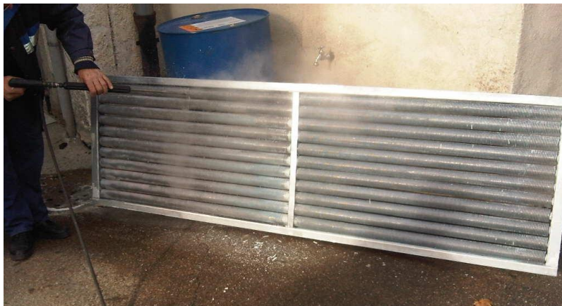
Reinigung eines großen Wärmetauschers vor Ort, mit Niederdruck-Heißreinigungsverfahren
