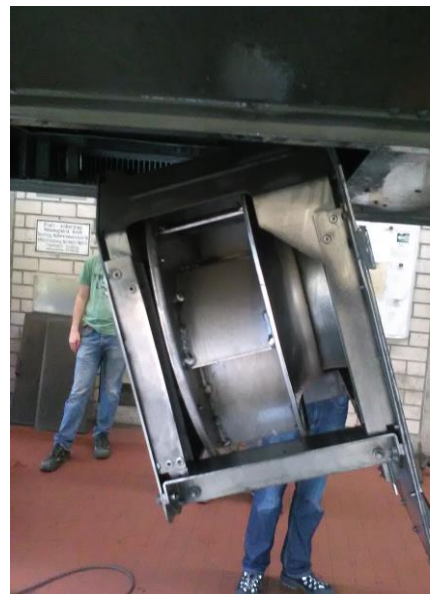
Wärmetauscher unter einer S-Bahn - Reinigung ohne komplette Demontage spart Zeit und reduziert Unfallrisiken
