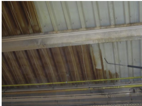
Über-Kopf-Reinigung an der Hallendecke – Detail
